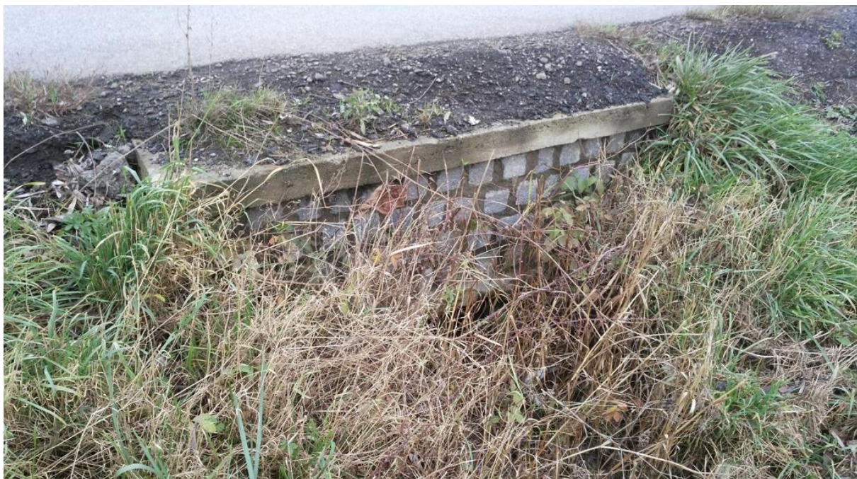
Propustek č.1 – pohled na výtokové čelo propustku
